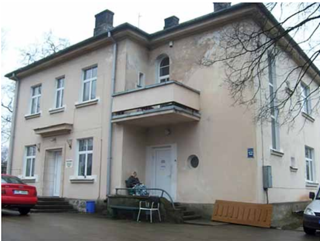
Sociālās aprūpes centrs šobrīd atrodas šajā ēkā Das Sozialzentrum von Kegmus Social Care Center of Kegums
